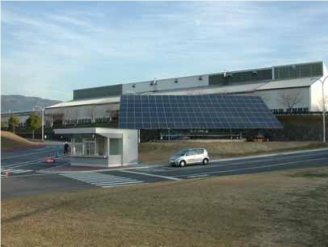
Die installierte Photovoltaikanlage auf dem Iga Campus
