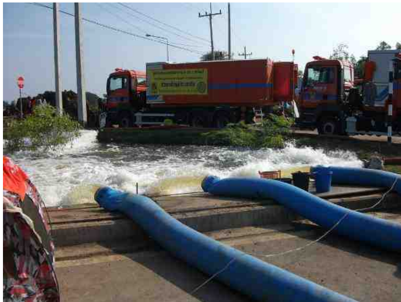
【アユタヤTC付近 排水の様子】
