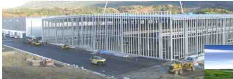
新組立工場の様子
